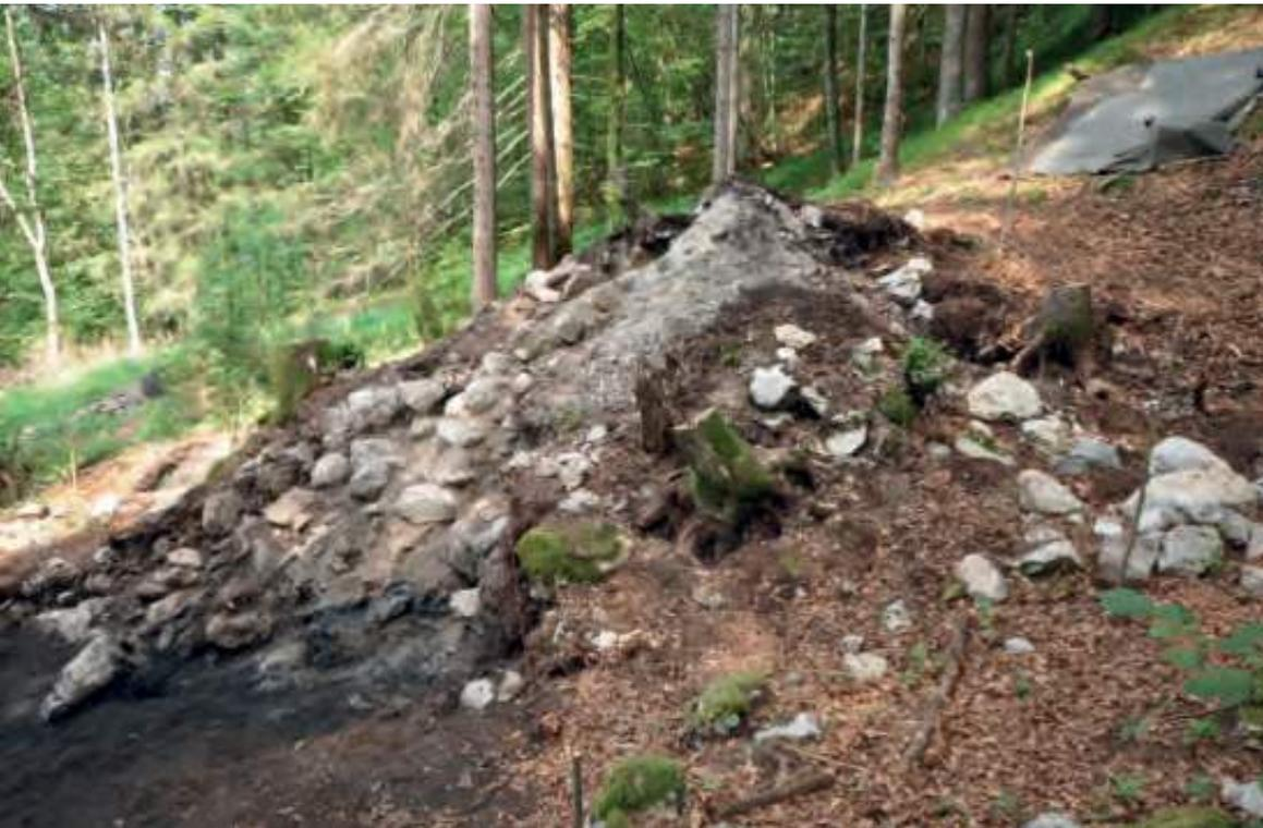
Der Stuckofen war aus Bruchsteinen gemauert und hatte eine annähernd quadratische Grundfläche mit etwa 4 × 4 m. Es wurden Kalksteine aus der Umgebung verwendet und Sandsteine in jenen Bereichen, die stärker der Hitze ausgesetzt waren. Die Höhe des Ofenschachtes kann nur mehr rekonstruiert werden. Sie muss mindestens 4 m betragen haben, mit dem anzunehmenden Kamin noch dementsprechend mehr.
