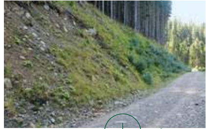
Böschung mit offenen Bodenstellen
