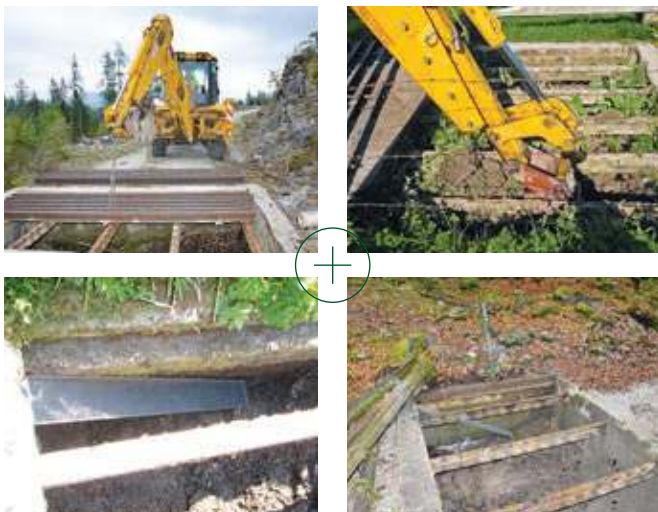
Entschärfung des Falleneffektes des Weiderosts durch Einbau einer Aufstiegshilfe für Amphibien .
